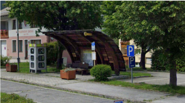
Bushaltestelle Gnesau Ortsmitte mit Haltepunkt Nockmobil (Quelle: Google Maps)
