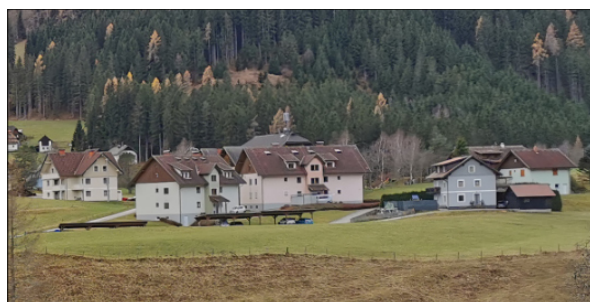
Geschoßwohnbau in der Ortschaft Haidenbach
