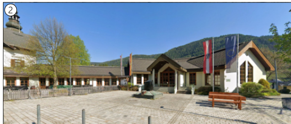
Bild 2: Hochwertige Platzgestaltung vor den Kulturhaus (Quelle: Google Maps)
