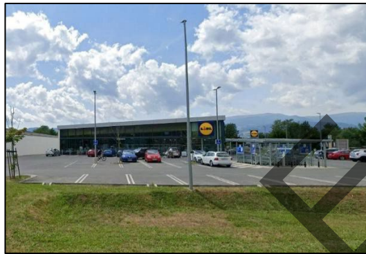
Blick auf die Ostfassade des Verbrauchermarktes (Quelle: Google Maps)
