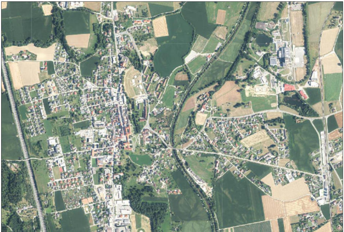
St. Andrä (Orthofoto, Befliegung 20.07.2022, Quelle: Kagis)
