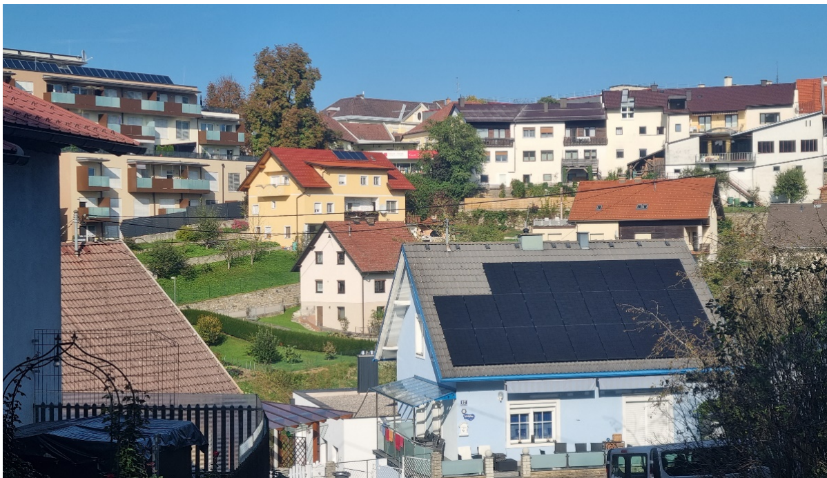
Hangbebauung mit Bestandsgebäuden und Neubau „Postplatzl“. Blick von Südwesten
