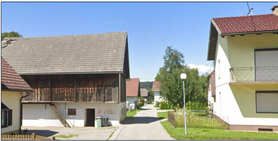
Gassendorf Goritschach (Quelle: Google Maps)
