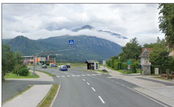
Geh- und Radweg an der Landesstraße B 82, Ortschaft Sittersdorf (Quelle: Google Maps)
