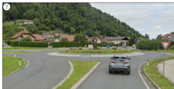
Bild 7: Fehlende Fußgängerquerungen am Kreisverkehr (B 82 / L 117) (Quelle: Google Maps)
