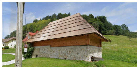
Renovierter Stadel in Kristendorf (Quelle: Google Maps)
