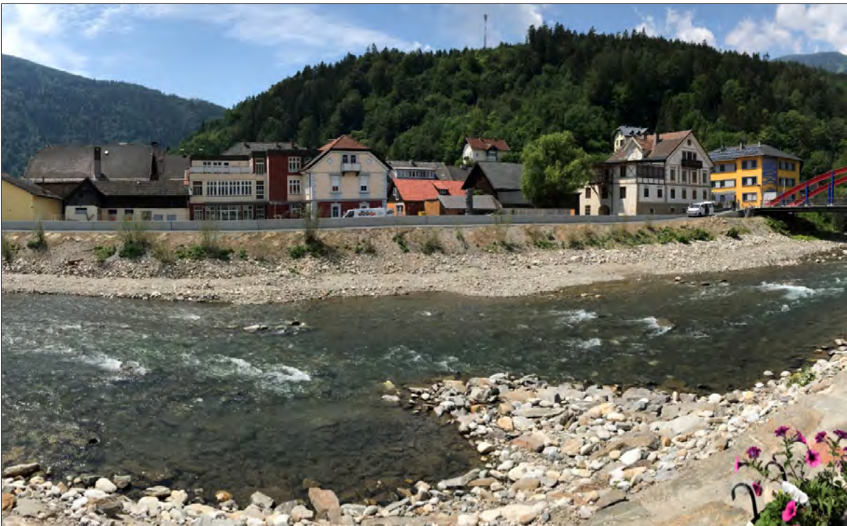
Ortskern Möllbrücke mit Hochwasserschutzanlage der Möll (Aufnahme Juni 2022)
