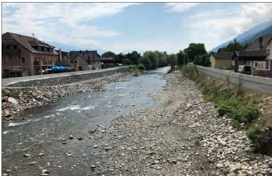
Möll mit Hochwasserschutzverbauung im Ortskern Möllbrücke
