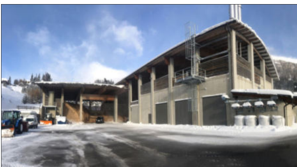
Biomasseheizwerk Katschberg (Quelle: RPK ZT-GmbH)
