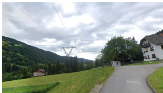
110-kV-Hochspannungsfreileitung im Bereich der Ortschaft Krangl (Quelle: Google Maps)
