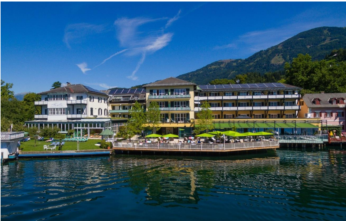
Abbildung 3: Südansicht des Gebäudebestandes (Quelle: Eigene Aufnahme)
