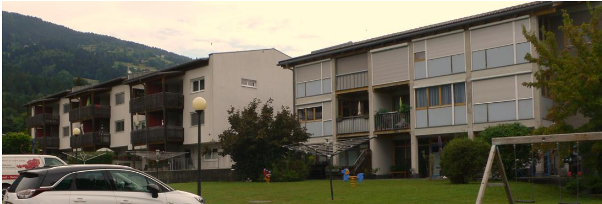
Abbildung 2: Bestandsgebäude im Ostteil des Grundstückes (Quelle: LWK)
