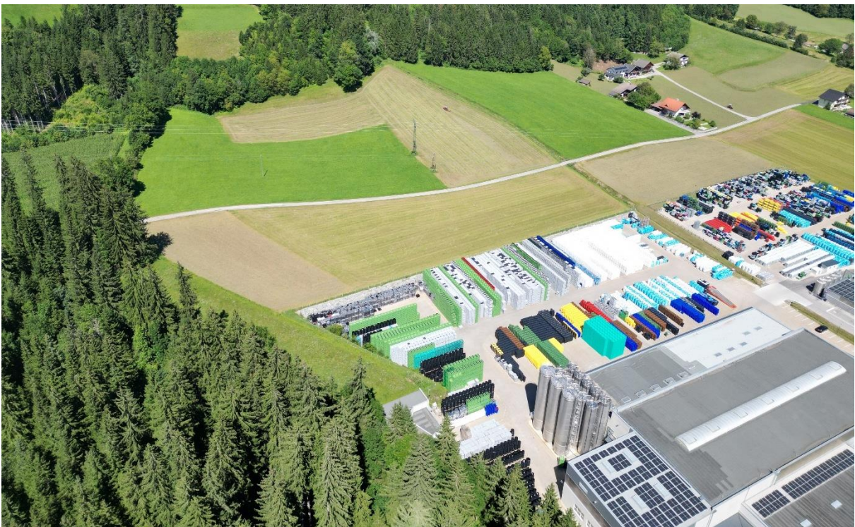
Abbildung 9: Blickrichtung nach Nordosten, Standort Silos Bestand (Quelle: LWK)
