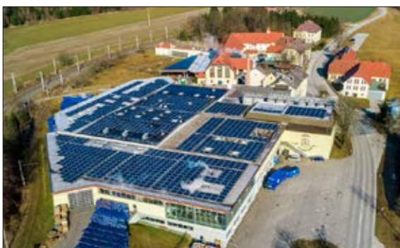
PV- Anlage Hirter Brauerei (Quelle: https://www.hirterbier.at )
