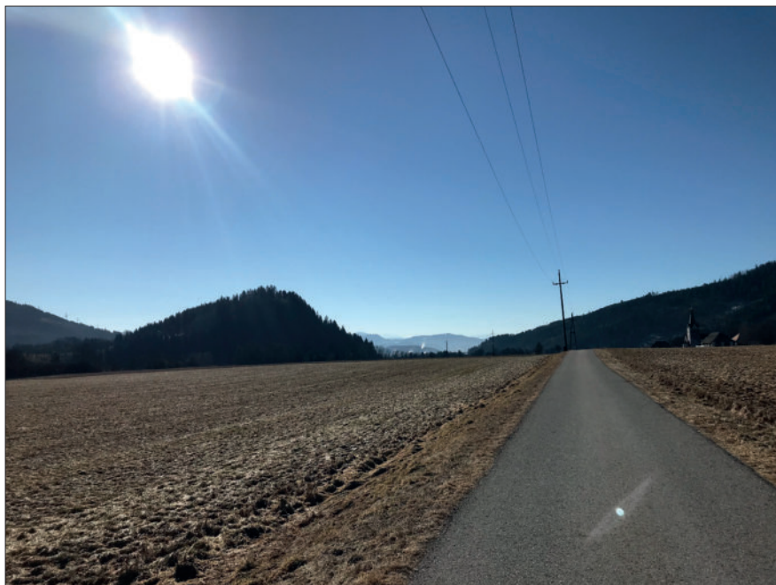
20kV- Leitung Micheldorf (Quelle: eigene Aufnahme)
