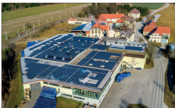
PV- Anlage Hirter Brauerei (Quelle: https://www.hirterbier.at )
