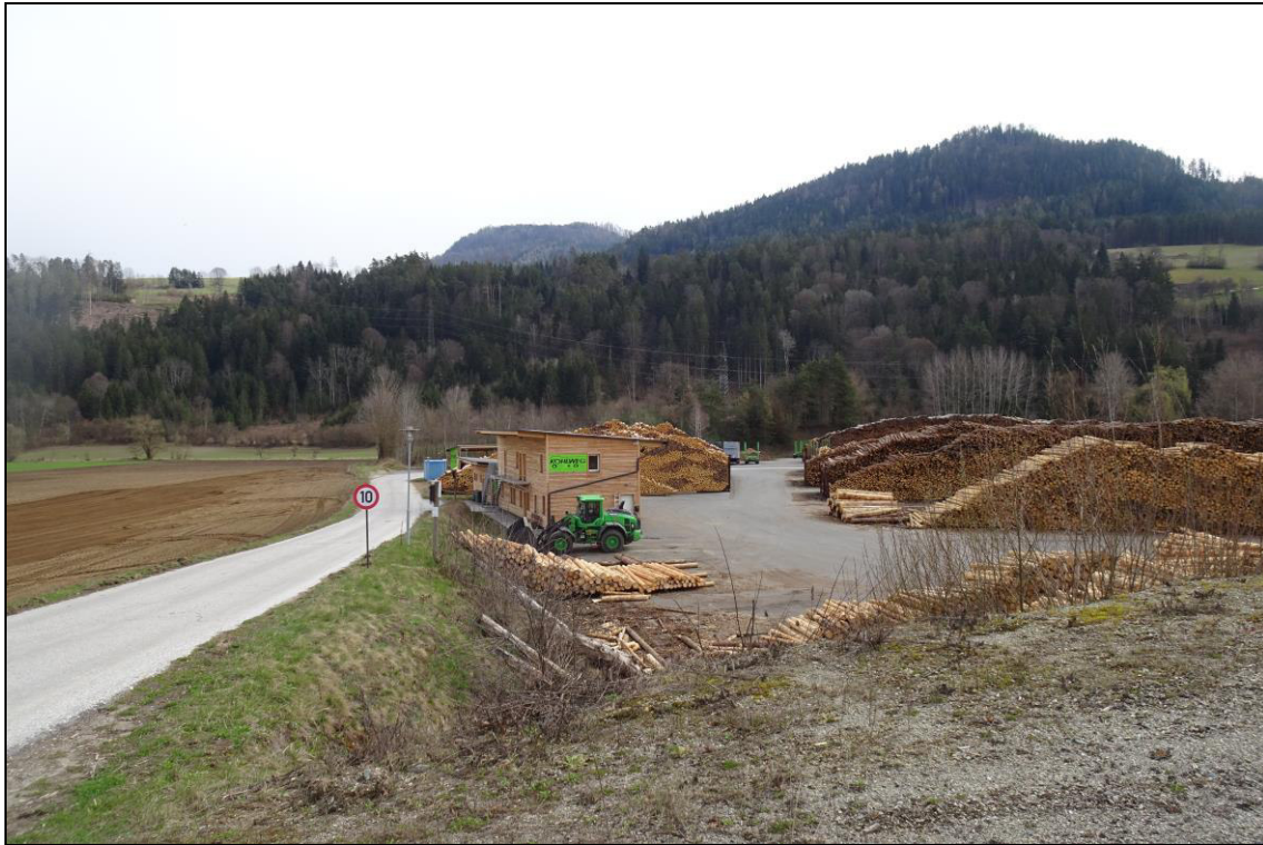
Foto 1 - Betriebsgelände mit Zufahrtsstraße und Bürogebäude
