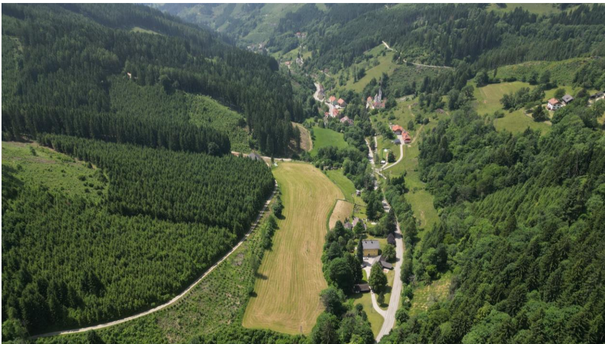
Abbildung 2: Straßendorf Lölling-Graben (Quelle: LWK 2025)
