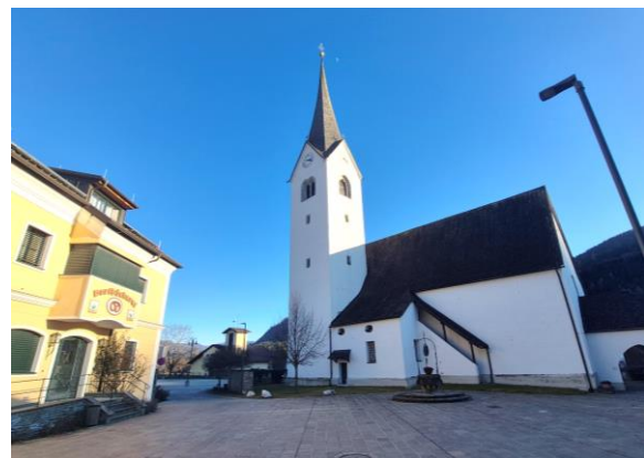
Abbildung 13: Dorfbäckerei und Pfarrkirche St. Salvator (Quelle: LWK 2024)
