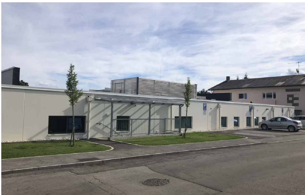
Foto 4: Spar Markt - Blick von der Josef-Friedrich-Perkonig-Straße (Von Norden nach Südwesten)
