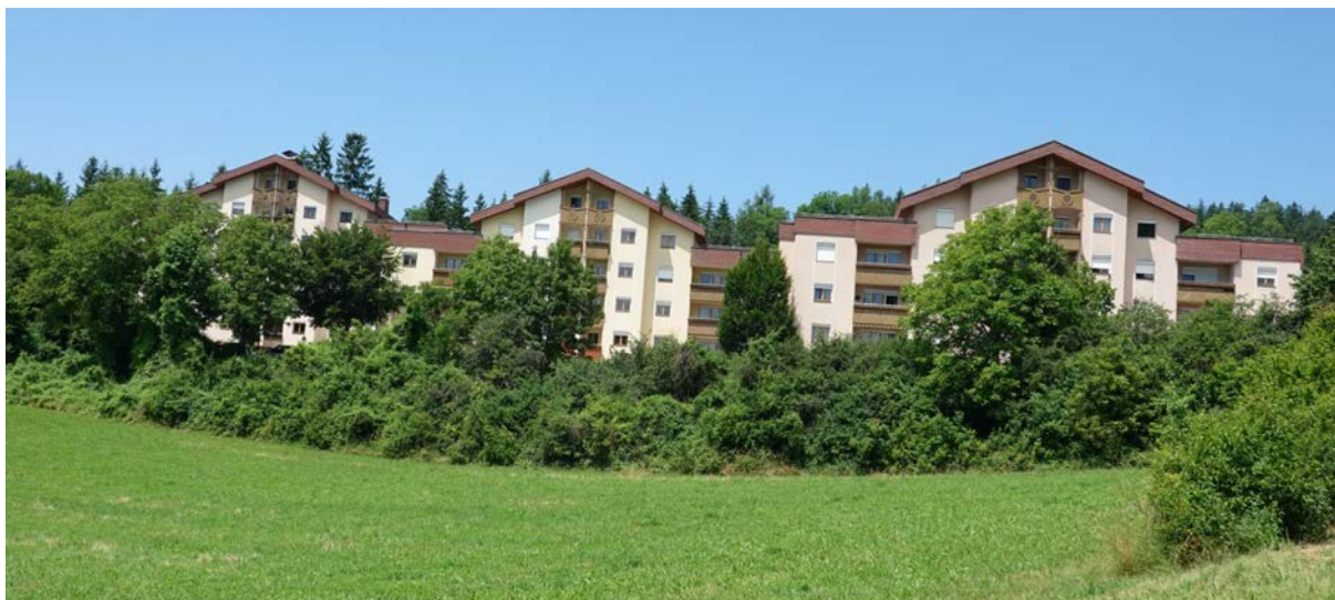
Foto 05,06,07: Nördlich angrenzende Geschößwohnbauten - talseitig
