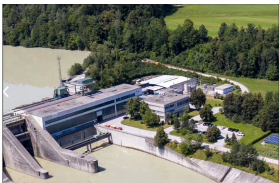
Draukraftwerk Feistritz-Ludmannsdorf (Quelle: Verbund)
