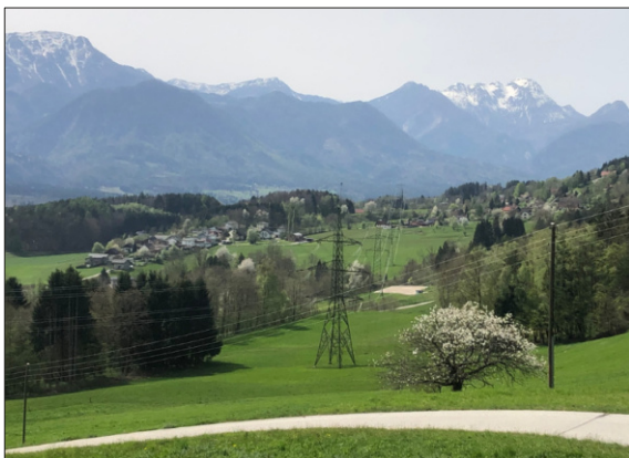
220-kV-Hochspannungsfreileitung bei Pugarad
