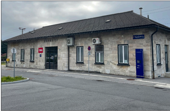
Bahnhofsgebäude (Eigene Aufnahme)
