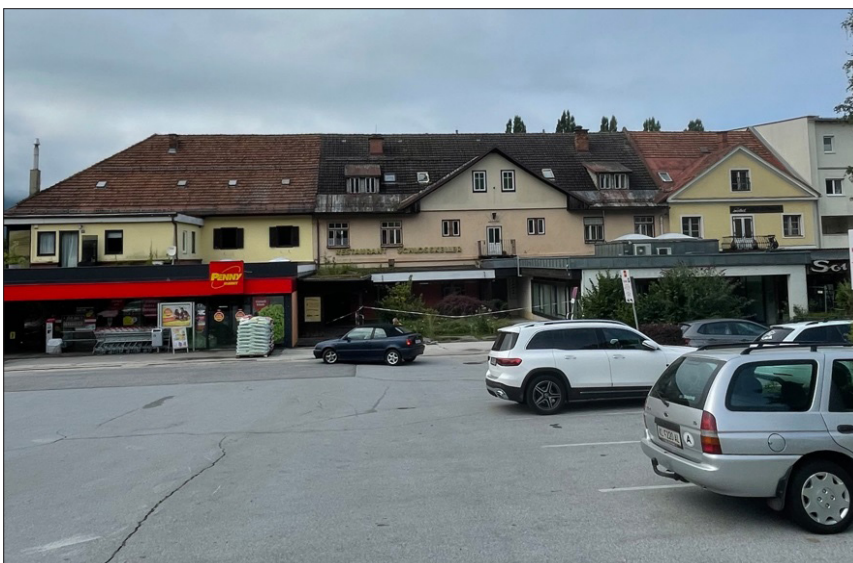
Sanierungsbedarf im Ortskern (Eigene Aufnahme)
