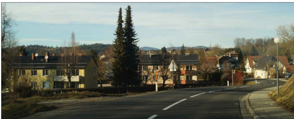
Geschosswohnbau in Brenndorf
