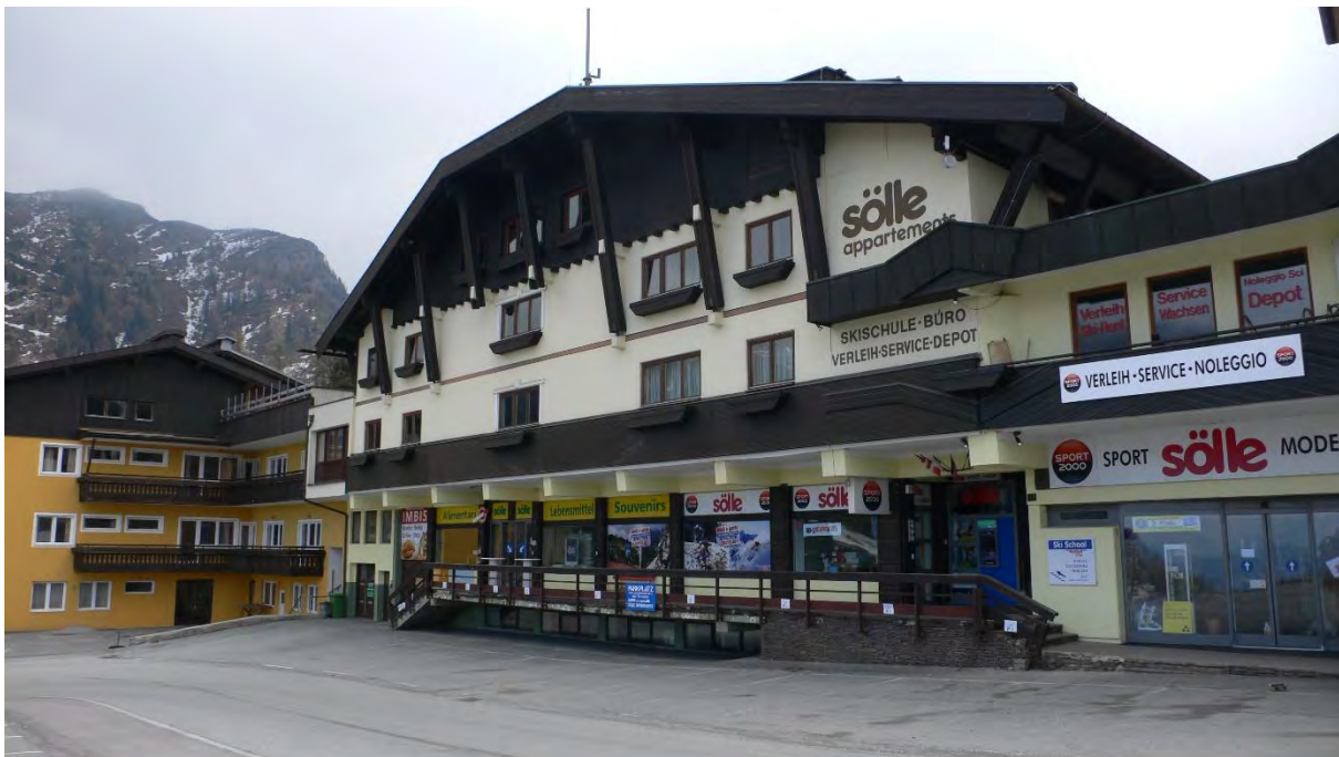
Abbildung 5: Ansicht vom Tressdorfer Almweg Richtung Süden (Quelle: LWK)
