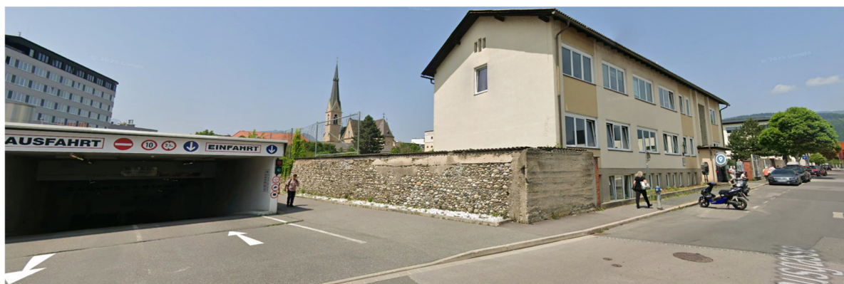
Abbildung 4: Fotos Bestandssituation (Quelle: Google Maps)
